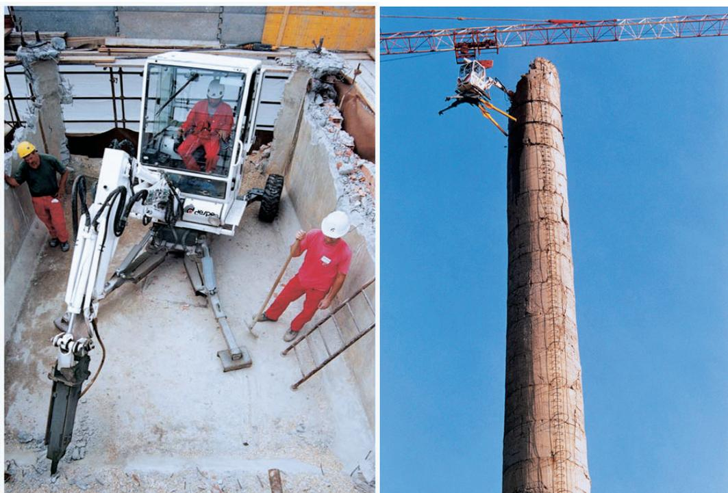
Fig. 22 – Demolizione. Demolizione di strutture in cemento armato con escavatore munito di martello idraulico (a sinistra) e di una ciminiera con l'utilizzo della stessa macchina radio e video controllata (a destra). (DESPE Srl)
