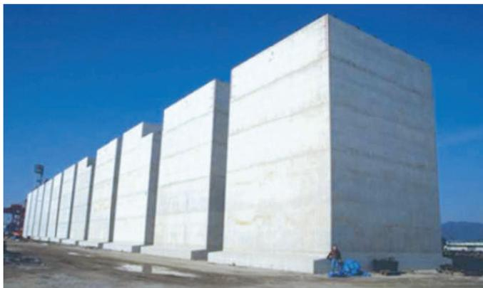
Fig. 14 – Cassoni autofondanti. Cassoni in calcestruzzo armato pronti per essere rimorchiati verso il sito di costruzione di un molo. Una volta sul posto saranno affondati riempiendoli con materiale inerte (APAT)
