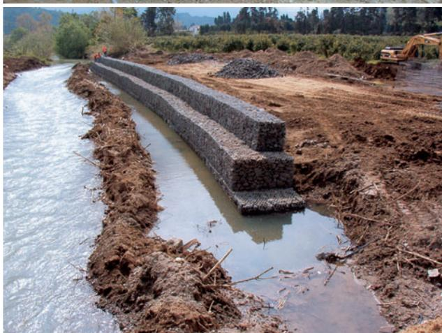
Fig. 28 – Gabbioni. Sopra, muro di contenimento realizzato in gabbioni; sotto, gabbionatura posta a protezione di una sponda fluviale (Officine Maccaferri SpA)
