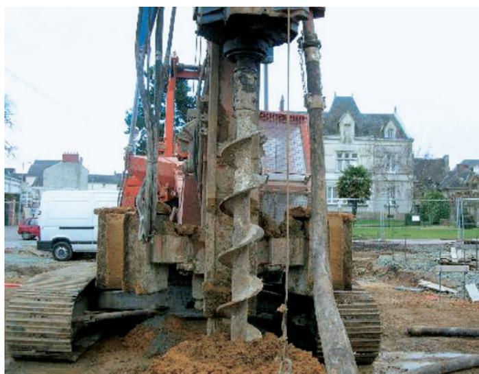
Fig. 41 – Trivellazioni. Trivellazione eseguita con sistema CFA; dalle aste cave viene iniettato il conglomerato cementizio (Trivel CAV Srl)
