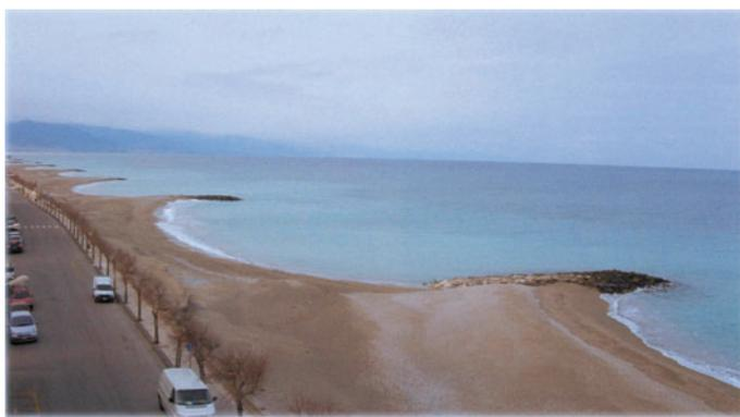
Fig. 33 – Pennelli (idraulici). Capo D'Orlando (ME): spiaggia protetta con un campo di pennelli; si noti la caratteristica forma dentellata (APAT).
