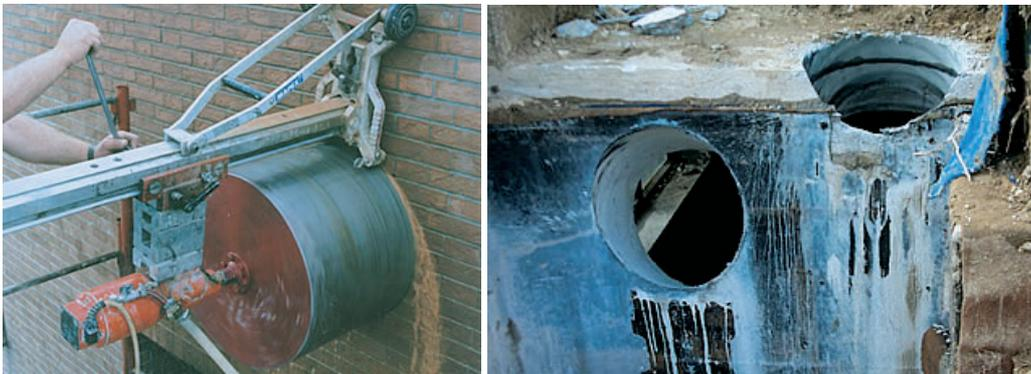
Fig. 12 – Carotaggi. A sinistra, macchina carotatrice con corona di grande diametro mentre pratica un foro in una parete in muratura; a destra, fori per la posa di cavidotti e tubazioni in una struttura in calcestruzzo armato (Architettura e ristrutturazioni Srl).
