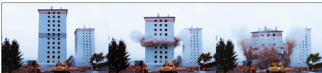
Fig. 21 – Demolizione. Demolizione di edifici civili con sistema idrodinamico di spinta controllato da computer remoto. (DESPE Srl)
