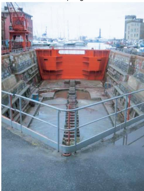
Fig. 8 – Bacini di carenaggio. Bacinetto di carenaggio del Porto Antico di Genova. È il più antico bacino di carenaggio in pietra del Mediterraneo e viene utilizzato per lavori sui rimorchiatori (Giovanni Casassa).
