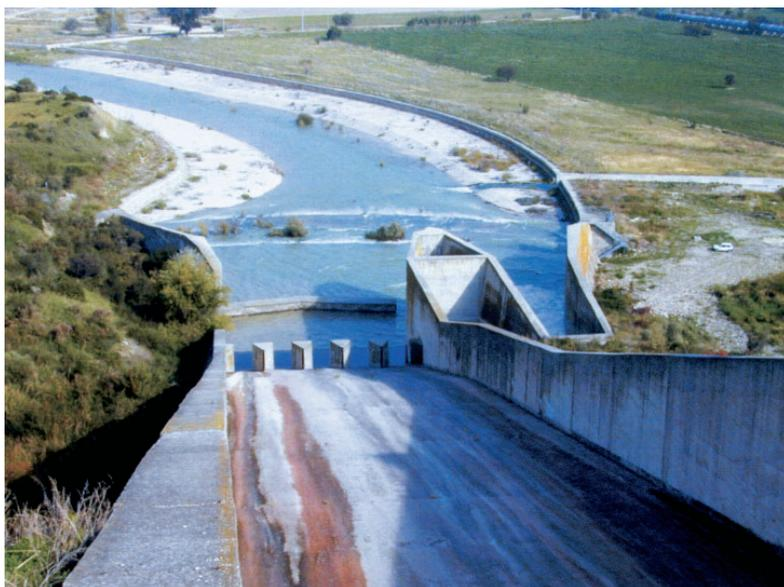
Fig. 38 – Scaricatori (per difesa idraulica). Scaricatore di superficie della diga del Liscione sul fiume Biferno (Guardialfiera, CB); al piede sono presenti dispositivi per la dissipazione dell'energia della corrente. Sulla destra è visibile l'imbocco dello scaricatore di fondo (APAT).
