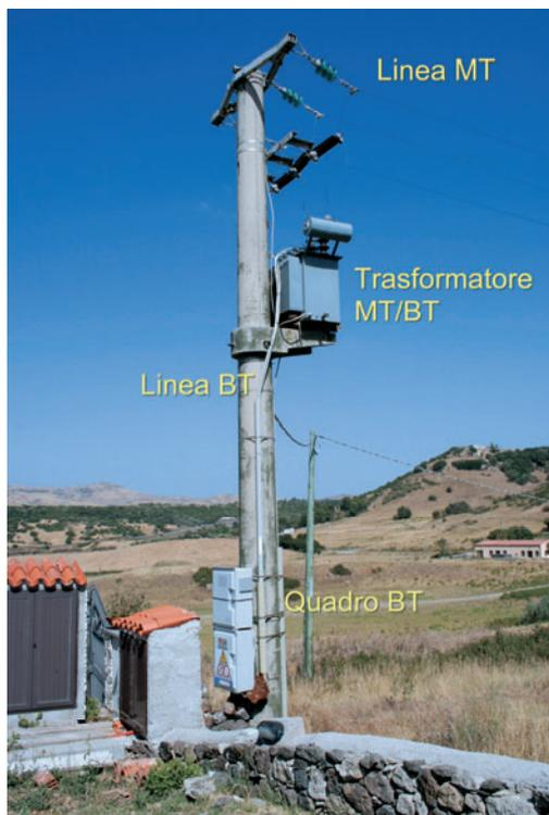
Fig. 10 – Cabine elettriche. Cabina di trasformazione su palo.
