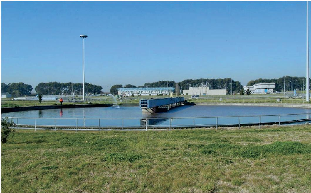
Fig. 25 – Disinquinamento. Vasca di ossidazione biologica di un impianto per il disinquinamento di acque fognarie. (Paolo Fioretti)
